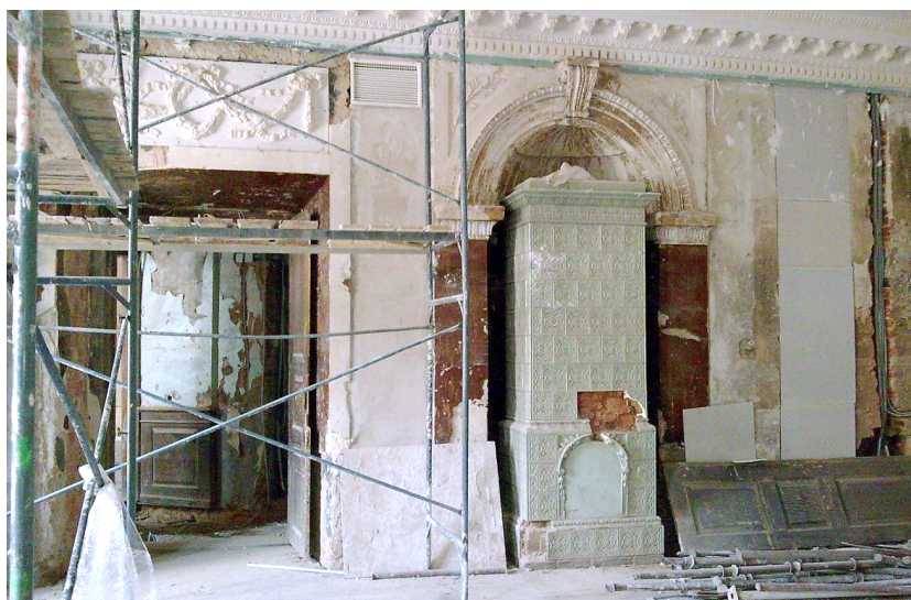
Малый столовый зал во время ремонтно-реставрационных работ, 2009 г.
