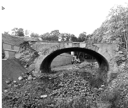
Ил. 7. Центральный пролет моста после демонтажа боковых арок, 2010 г.
