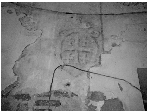
Ил. 23. Зондаж с фрагментом росписи на стене часовни, 2009 г.
