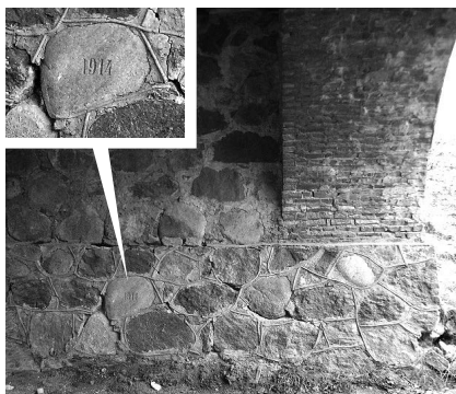
Ил. 8. Кладка центрального пролета моста с датой «1914» на одном из камней
