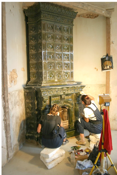
Реставрация печи в кабинете князя, 2009 г.
