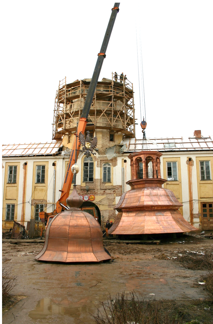
Начальный этап установки купольных конструкций на надвратную башню, 2005 г.
