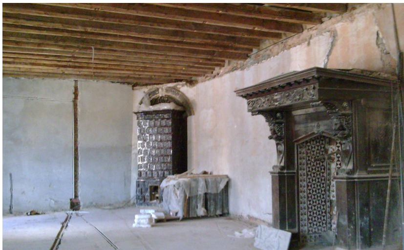
Каминный зал во время ремонтно-реставрационных работ, 2009 г.
