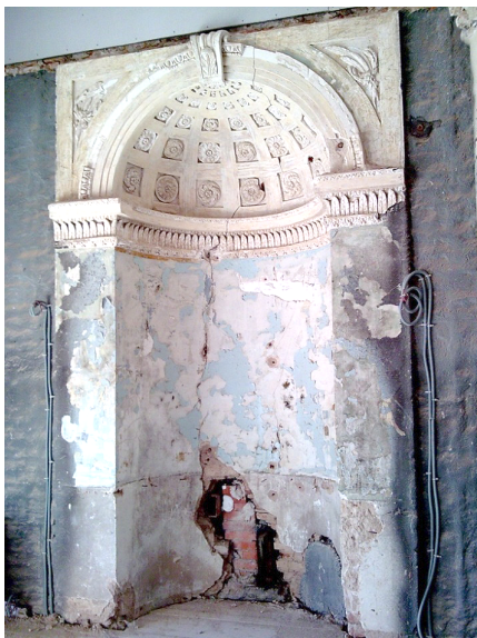
Ниша с выходом дымохода, Бальный зал
